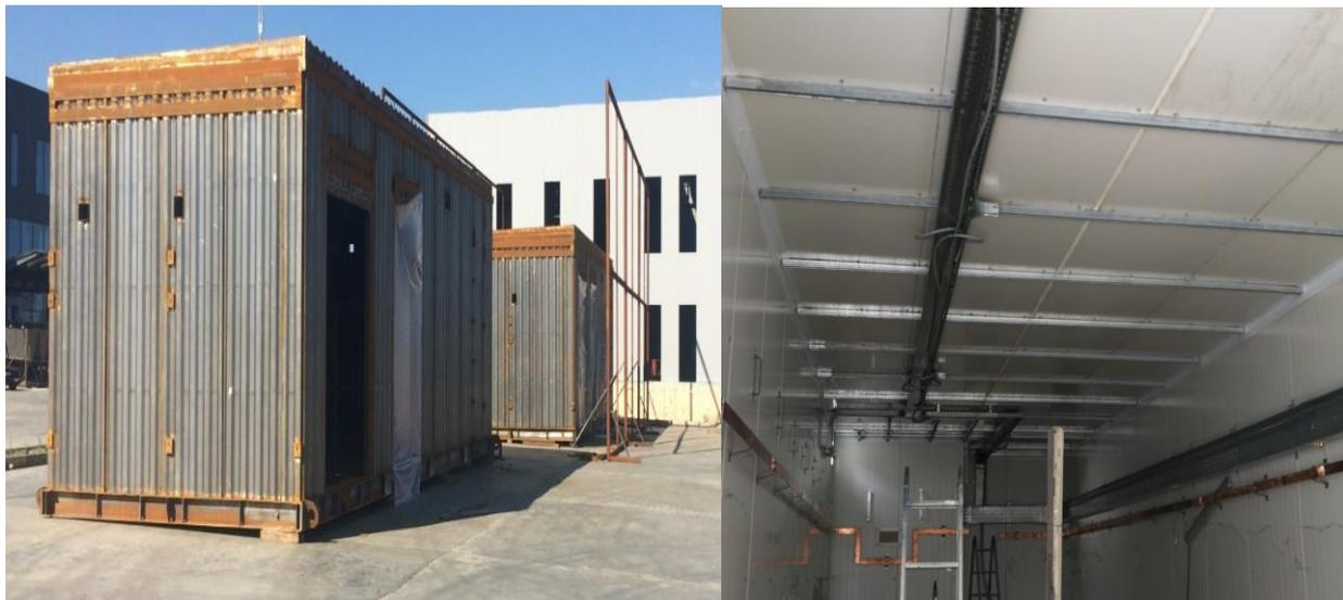
**Рисунок 2.9 – Варианты сборки до покраски и монтаж с установленными сэндвич-панелями и выполненной покраской**
