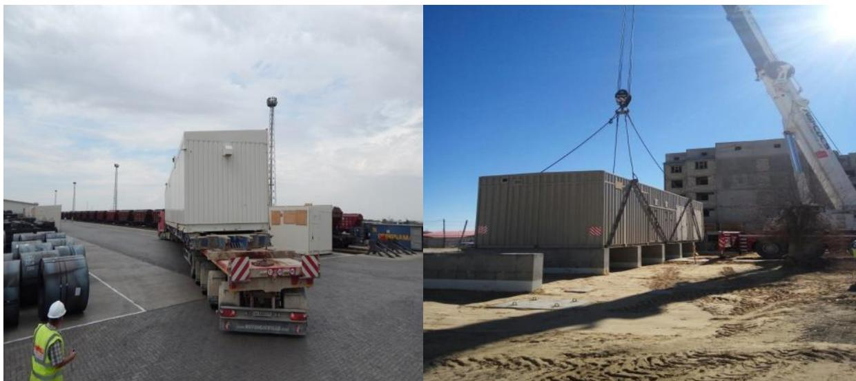
**Рисунок 2.3 - Внедренное решение: модульное сооружение собрано, произведено и протестировано на заводе-изготовителе**
