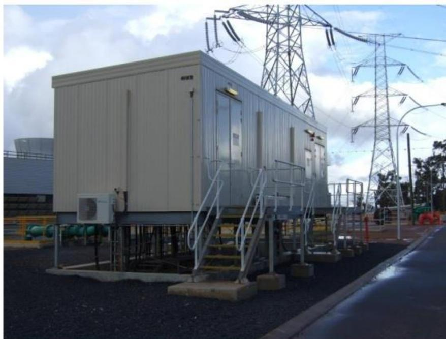
**Рисунок 2.1 – Модуль заводской сборки типа E-House**
